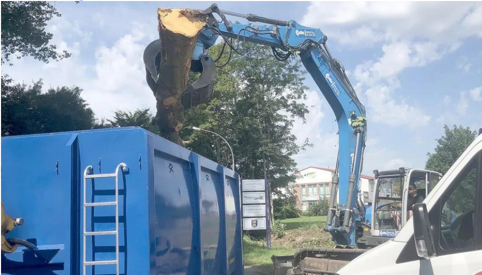
Am Donnerstag wurden in der Nähe der Friesenbrücke Bäume gefällt und das Holz abtransportiert. Foto: Vogt
