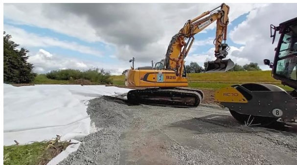
Die Fläche wird vorbereitet. Foto: Vogt
