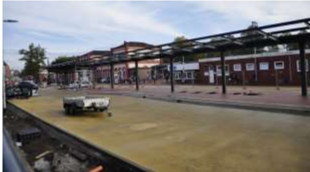
Die Bauarbeiten am Zentralen Omnibusbahnhof in Leer laufen nach Plan. Foto: Bodo Wolters
